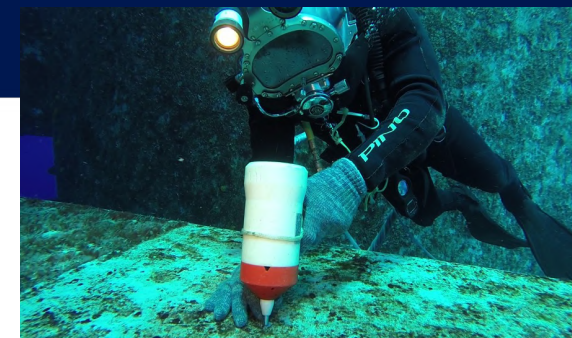
Medição de Potencial Eletroquímico
